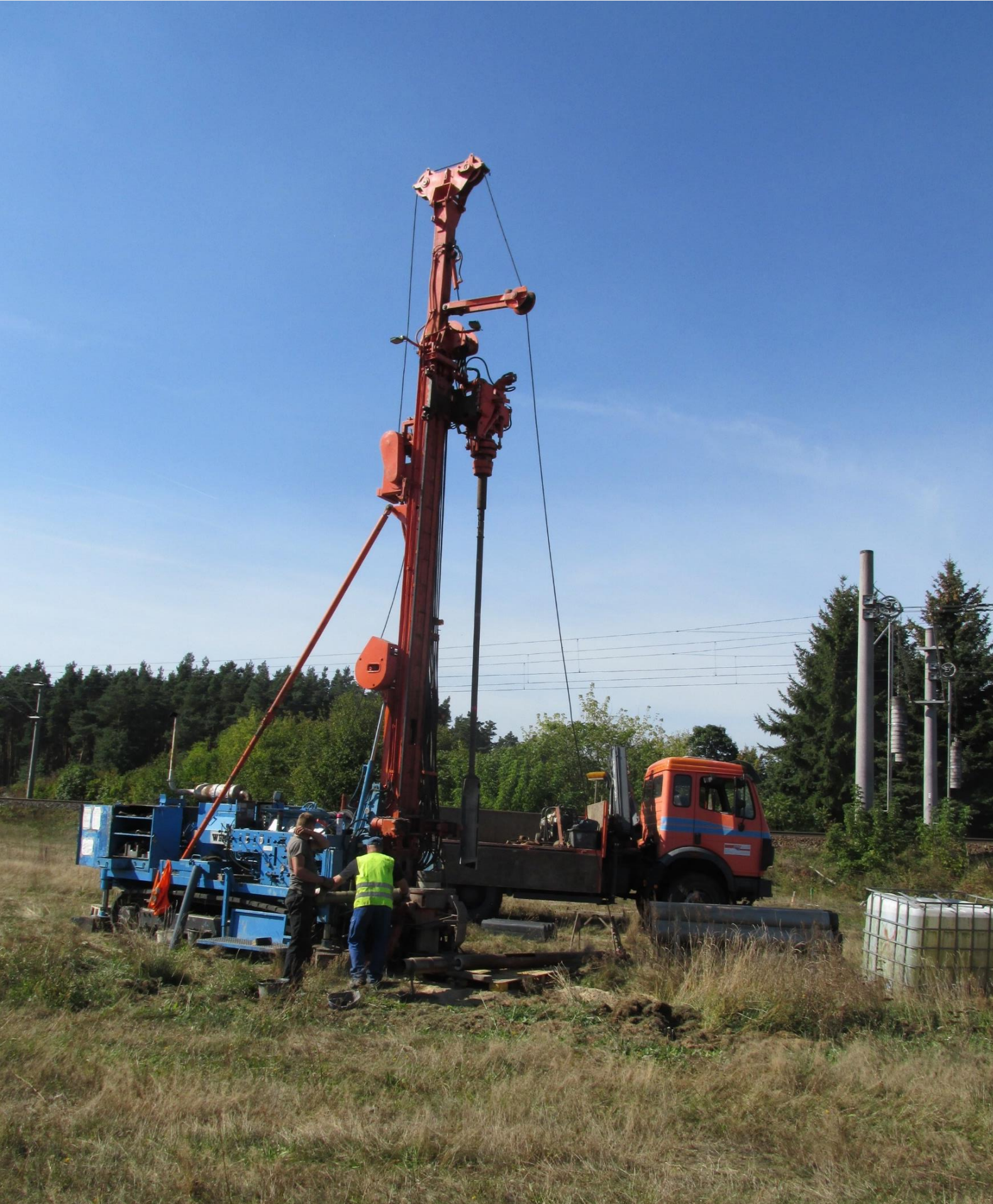
Hydrogeologische Baugrunduntersuchung / Herstellung Grundwasser-Messstellen
