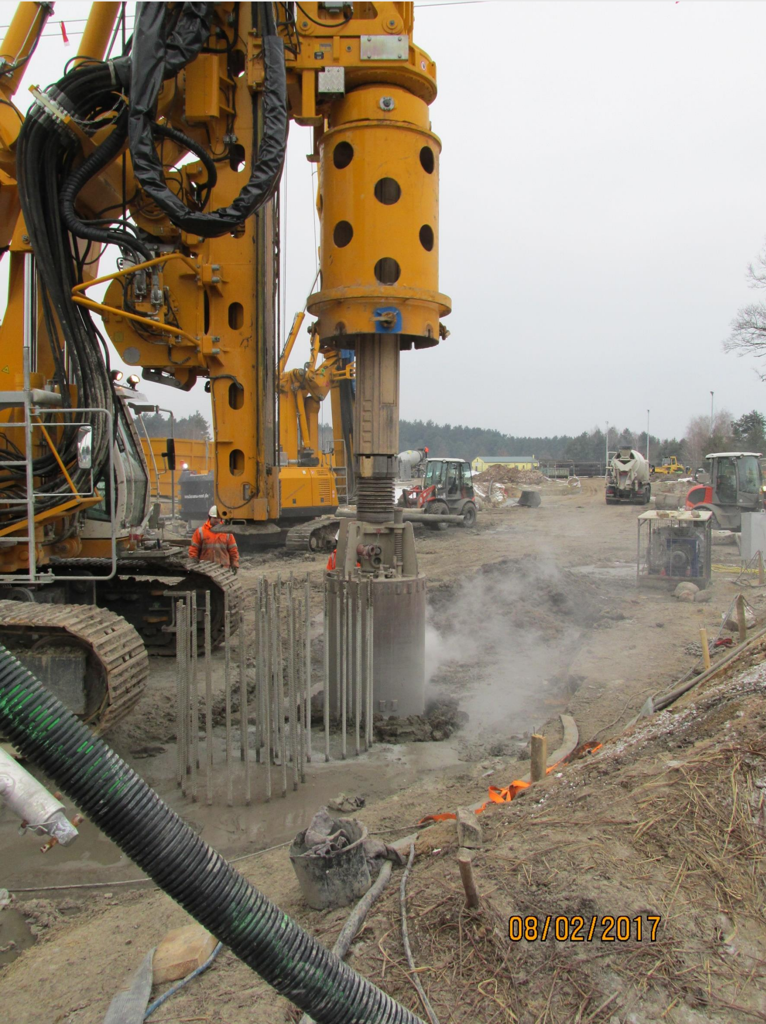
Einbringung von Betonpfählen
