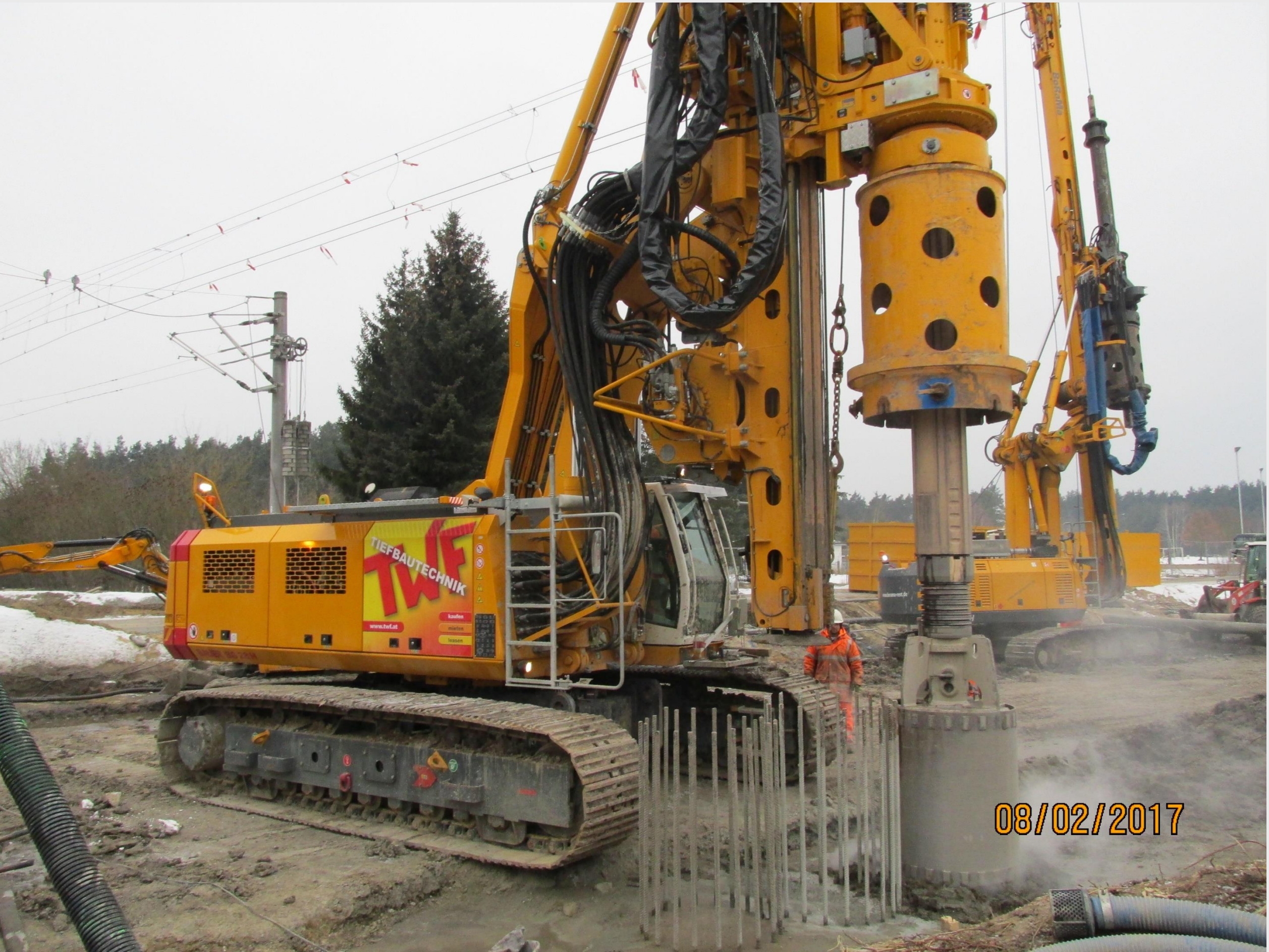
Einbringung von Betonpfählen
