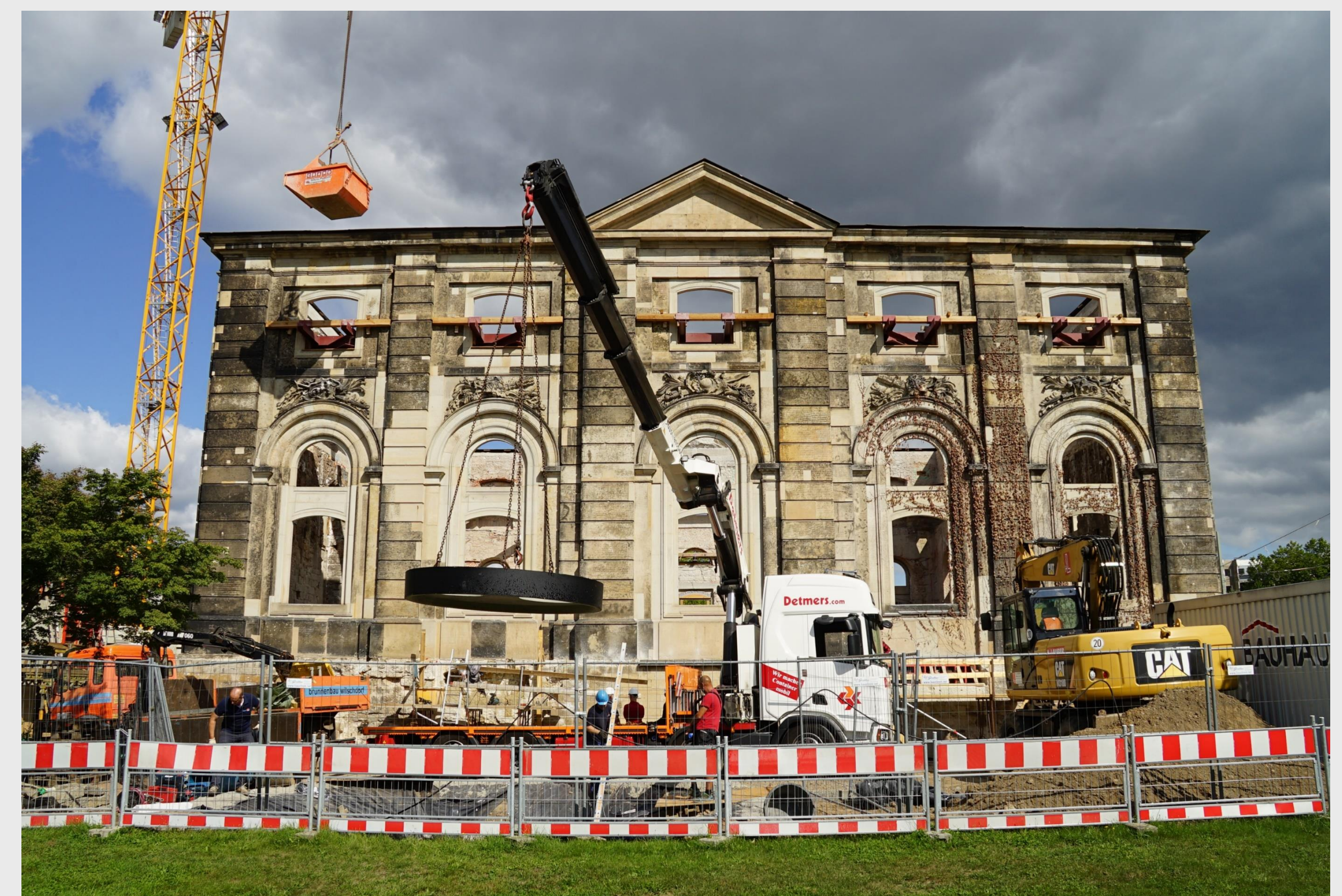
Einbringung Schachtdeckel, Ansicht von den Elbwiesen
