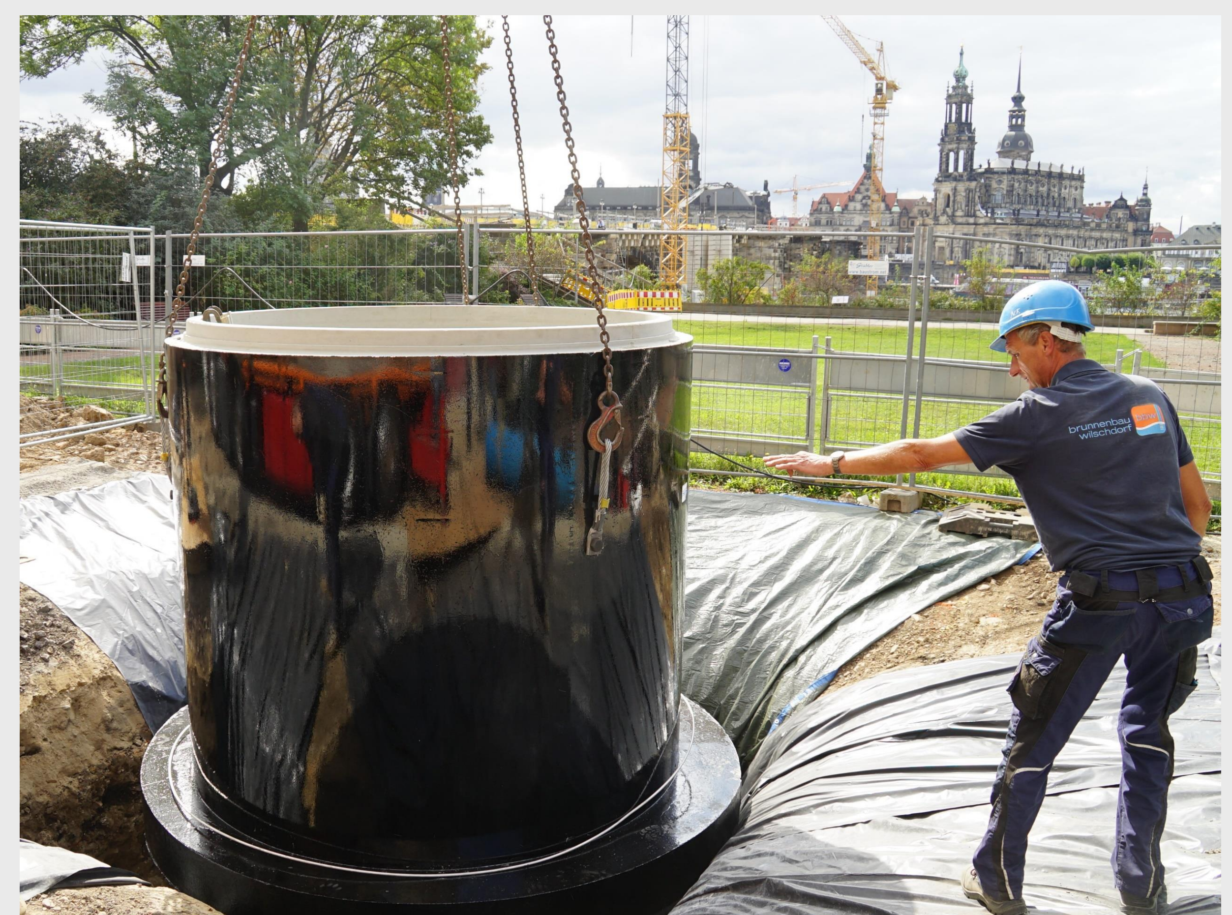
Einbringung Schachtring und -boden
