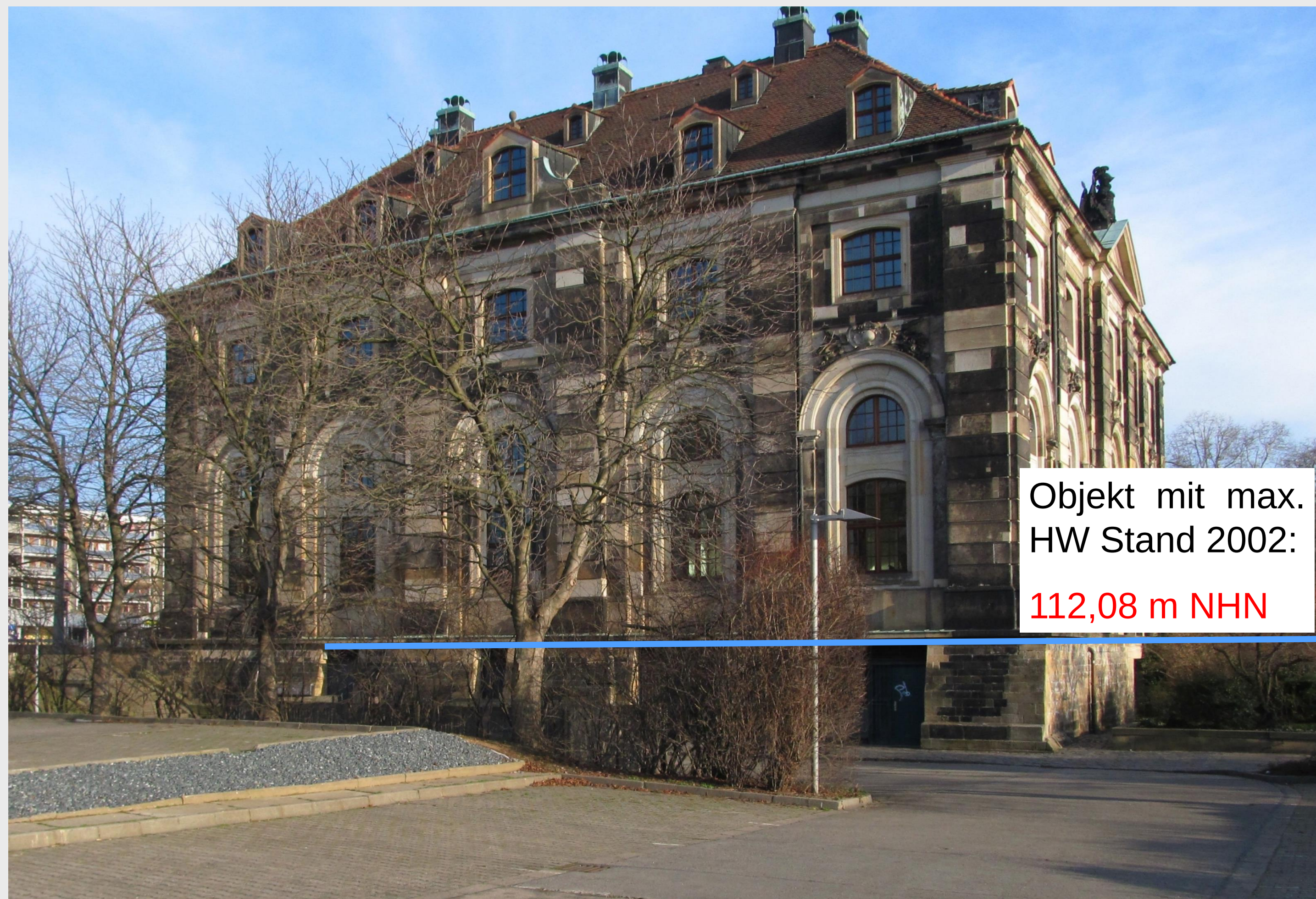
Objekt „Blockhaus Dresden“, GOK Eingang ca. 112,1 - 112,2 m NHN
